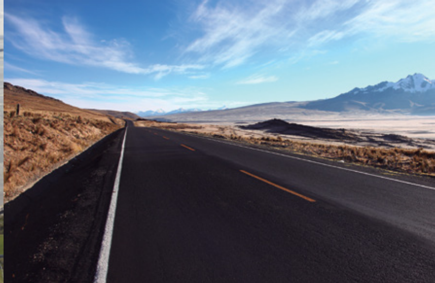
CARRETERA CONOCOCHA, YANACANCHA, PERU
