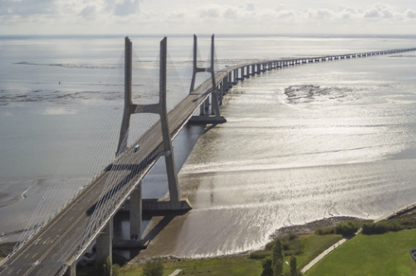
PONTE VASCO DA GAMA, LISBOA
